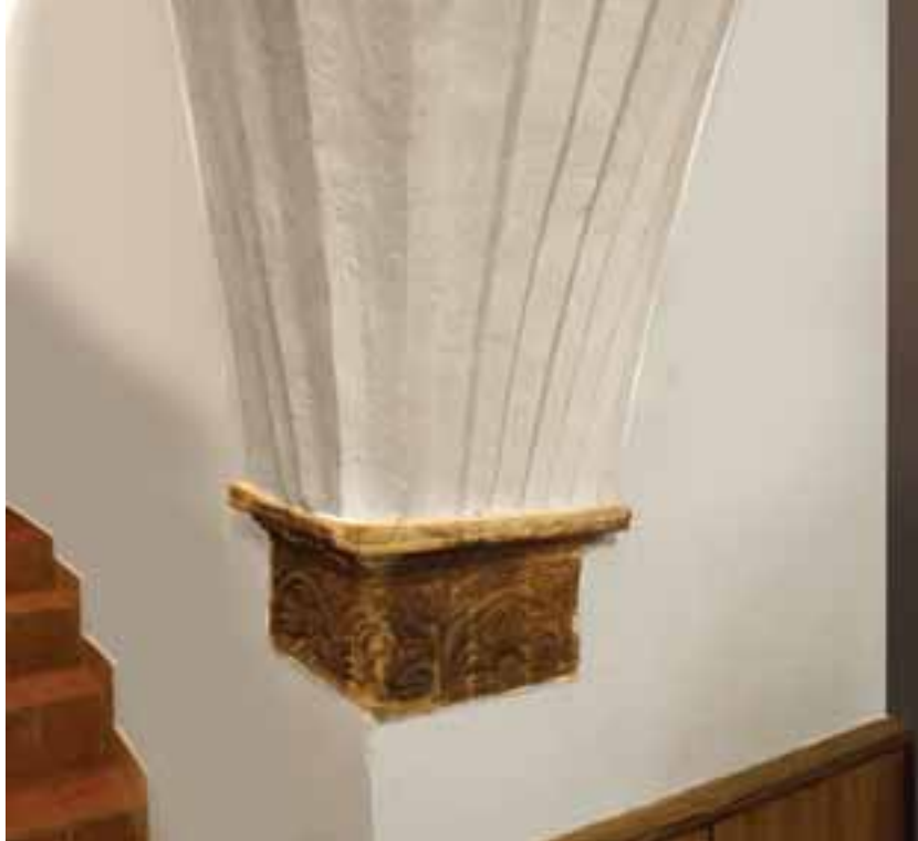
Klenební patka ve vstupní síni
