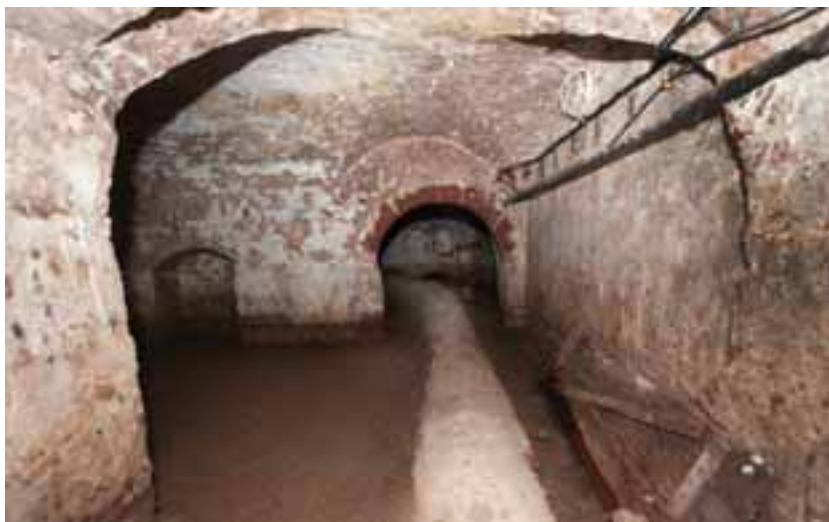
Sklep s gotickou valenou klenbou
