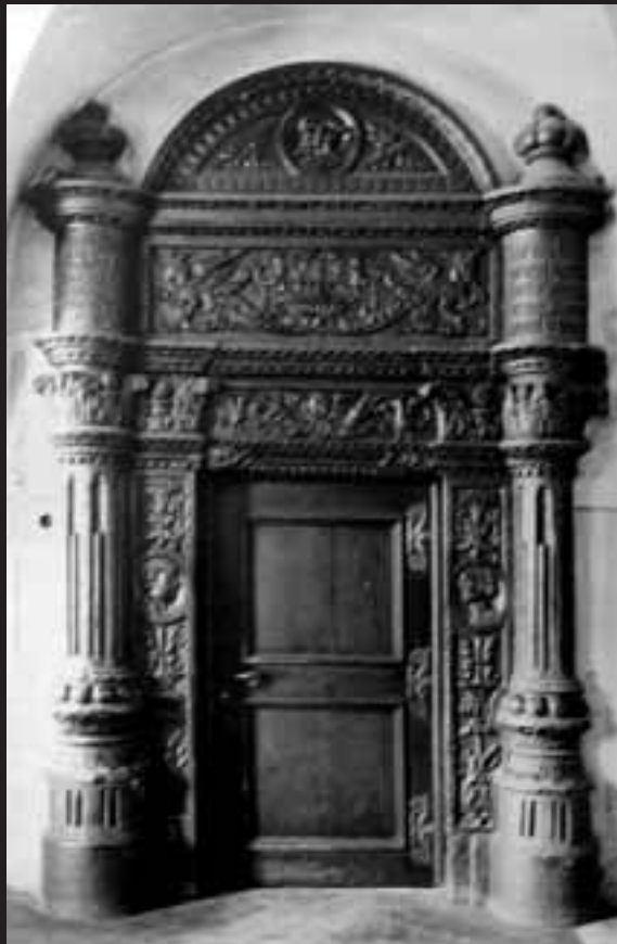
Portál měšťánského domu čp. 146/18
