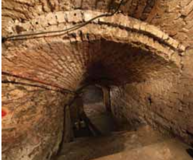
Bránská čp. 184/7 – sklep ze zámku
