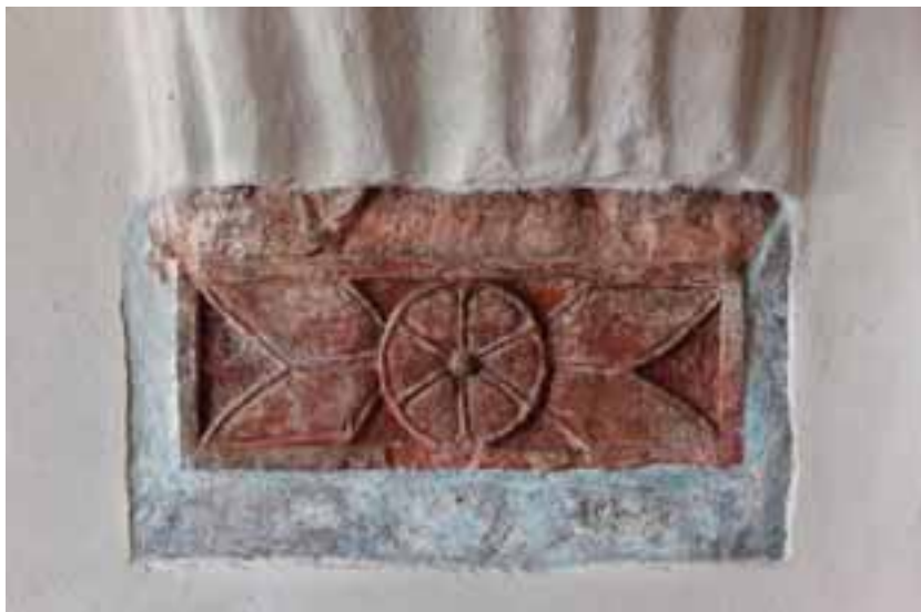
Klenební konzola a klenba v dolní síni
