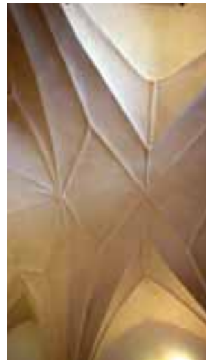
Klenební konzola a klenba v dolní síni
